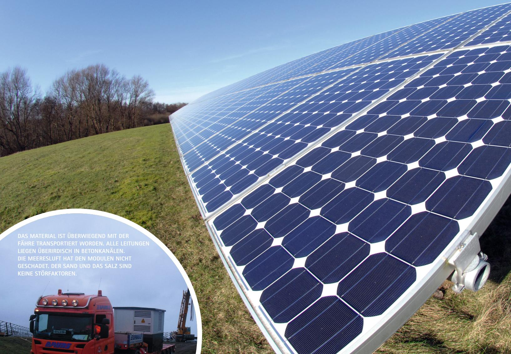
DAS MATERIAL IST ÜBERWIEGEND MIT DER FÄHRE TRANSPORTIERT WORDEN. ALLE LEITUNGEN LIEGEN ÜBERIRDISCH IN BETONKANÄLEN. DIE MEERESLUFT HAT DEN MODULEN NICHT GESCHADET. DER SAND UND DAS SALZ SIND KEINE STÖRFAKTOREN.
